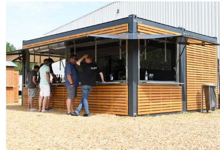
20 Fuß Container mit Holzverkleidung und Lager-Modul an der Rückseite
